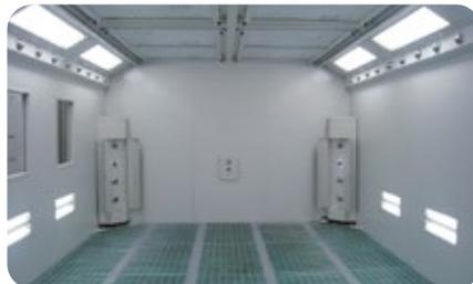
Lüftungsanlagen für Lackier- und Spritz-Kabinen.
